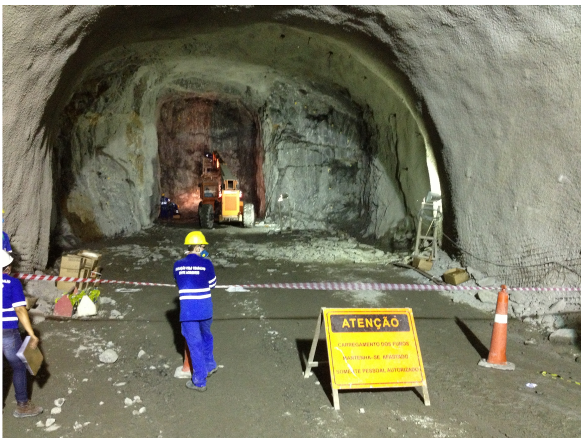
Figura 27. Frente de serviço sinalizada e isolada. Fonte: Acervo da empresa.
