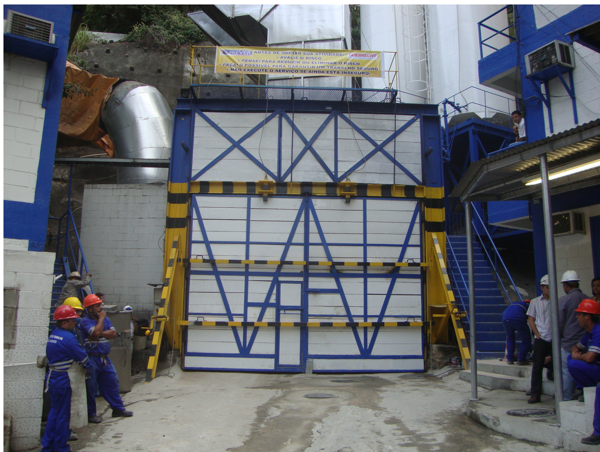
Figura 20. Portão de Isolamento e único acesso ao Túnel da obra estudada. Fonte: Acervo da empresa.
