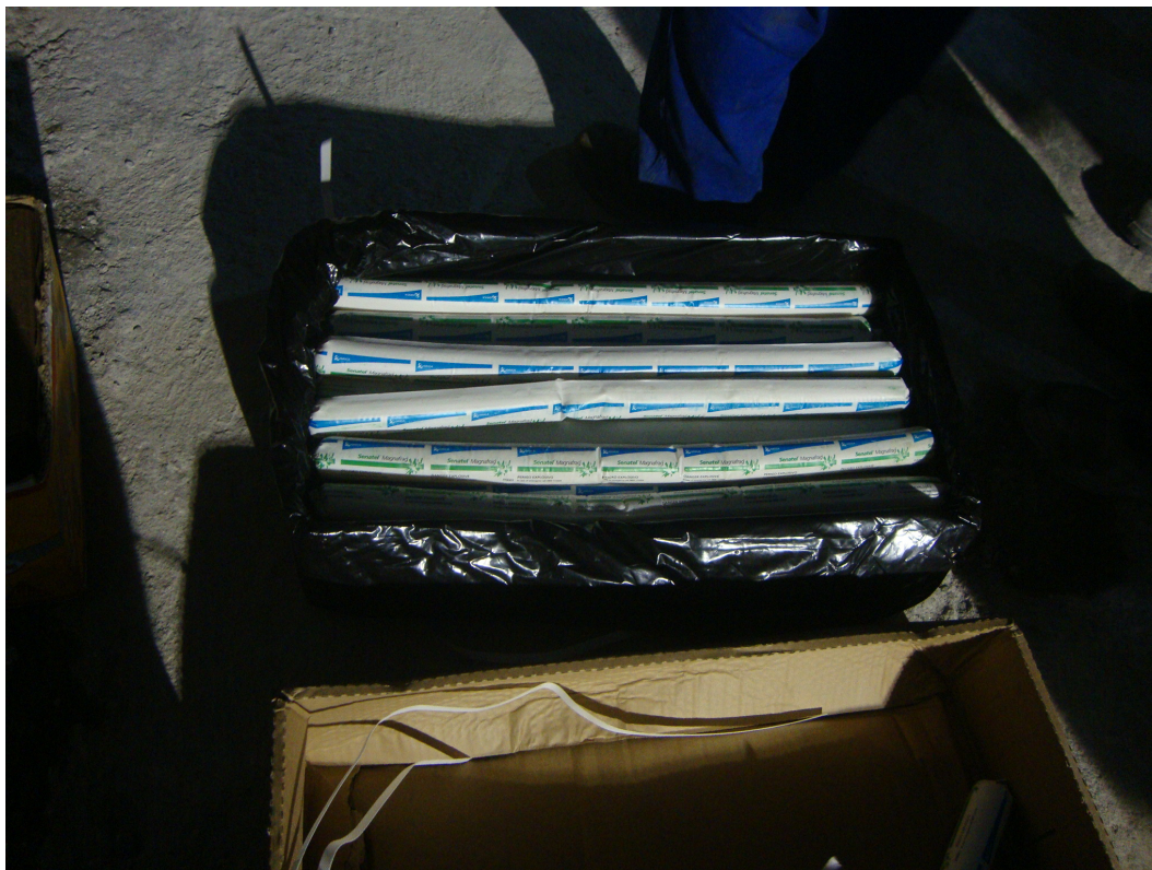
Figura 22. Explosivos transportados separado dos acessórios. Fonte: Acervo da empresa.
