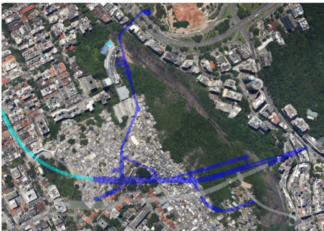
Figura 15. Implantação da obra Expansão General Osório. Fonte: Acervo da obra Expansão General Osório.
