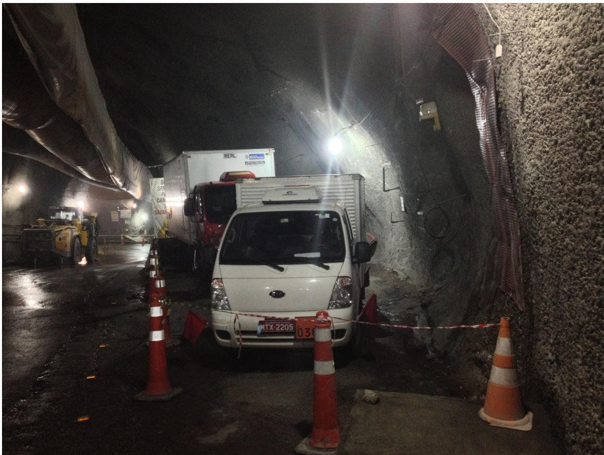
Figura 28. Caminhões utilizados como paiol móvel em área isolada. Fonte: Acervo da empresa.
