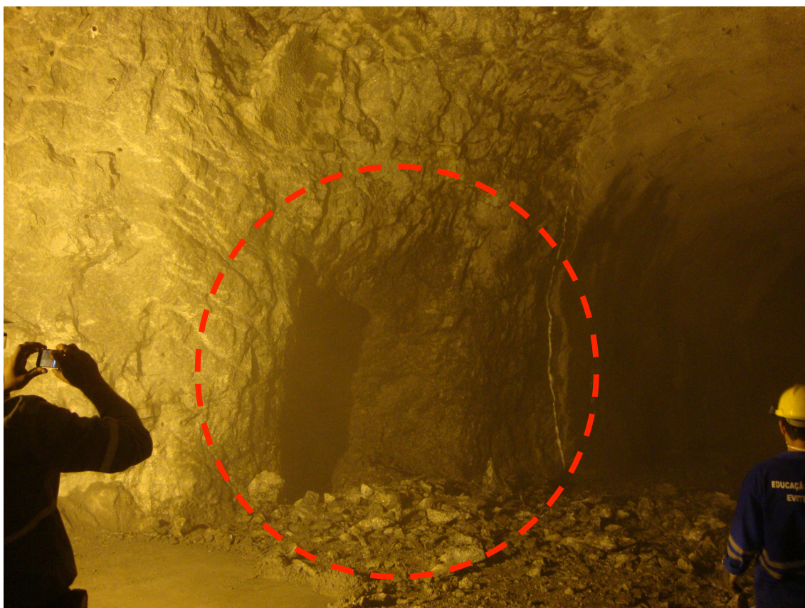
Figura 13. Foto depois da detonação, em outro ângulo, mostrando o avanço na área marcada. Fonte: Acervo da empresa.
